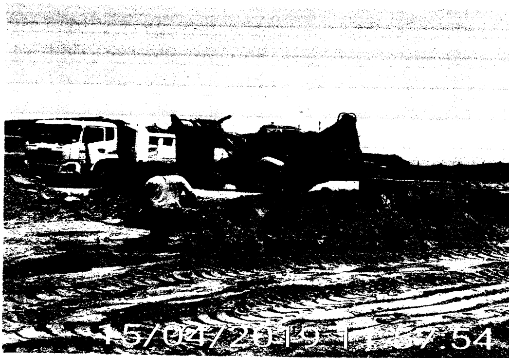
Imagen N°12: A la vista de la imagen se aprecia que se está eliminado material propio de excavaciones y material procedente de demolición con ayudada de un volquete y la retroexcavadora.
