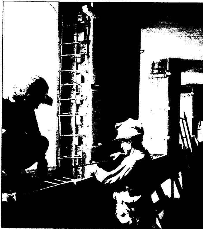
Colocación de encofrado de las columnas en el área de Frio
