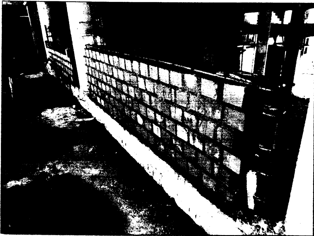
Asentado de ladrillo de cabeza en mezanine de Tareas previas
