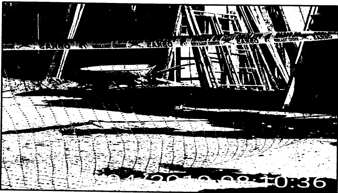
Imagen N°15: A la vista de la imagen se aprecia que los materiales de obra están señalizados con cintas Y mallas de seguridad.
