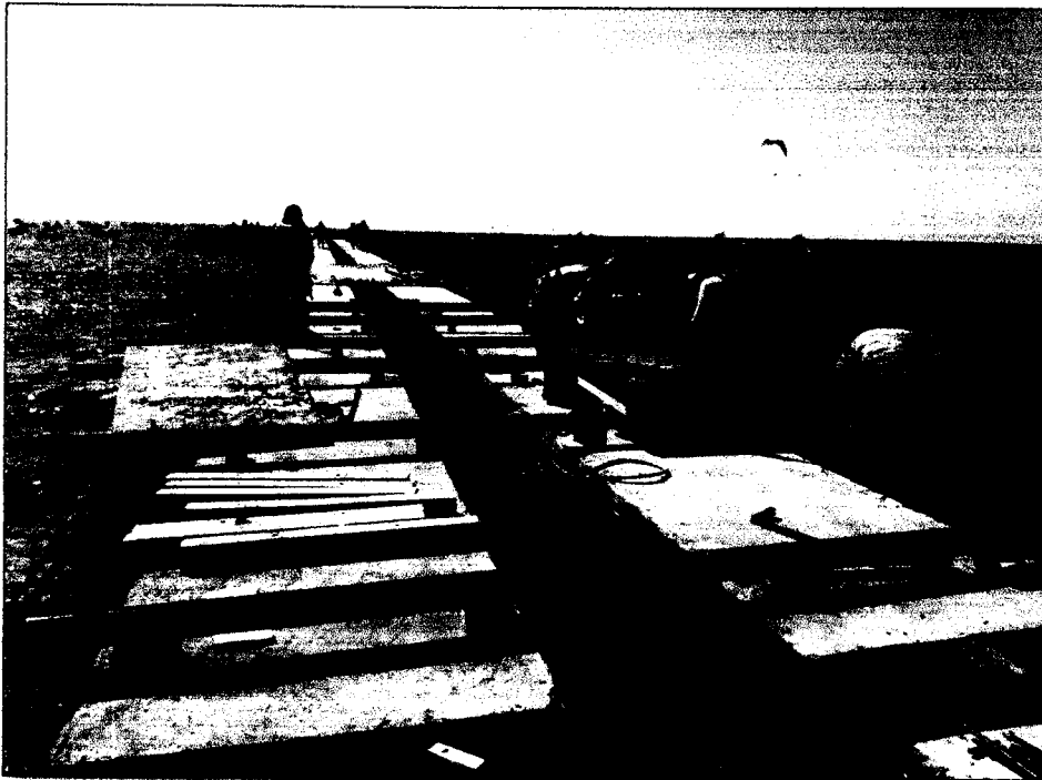
Obras de Mar – Encofrado de las juntas longitudinales y transversales en el puente
